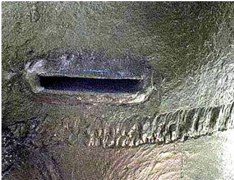
Figura 4 - Cordão de Solda
